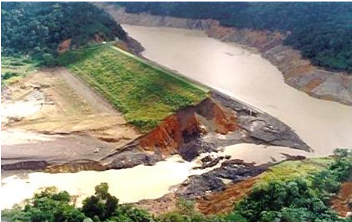
El Guapo Dam Failure (Hidroven 2000)
