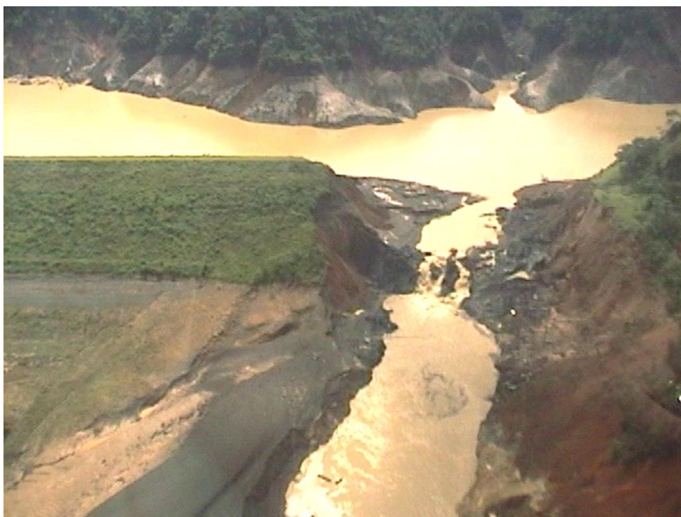
Figure B.3- 10 El Guapo failure. (Hidroven, 1999)
